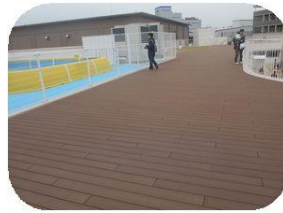
2階のウッドデッキ
